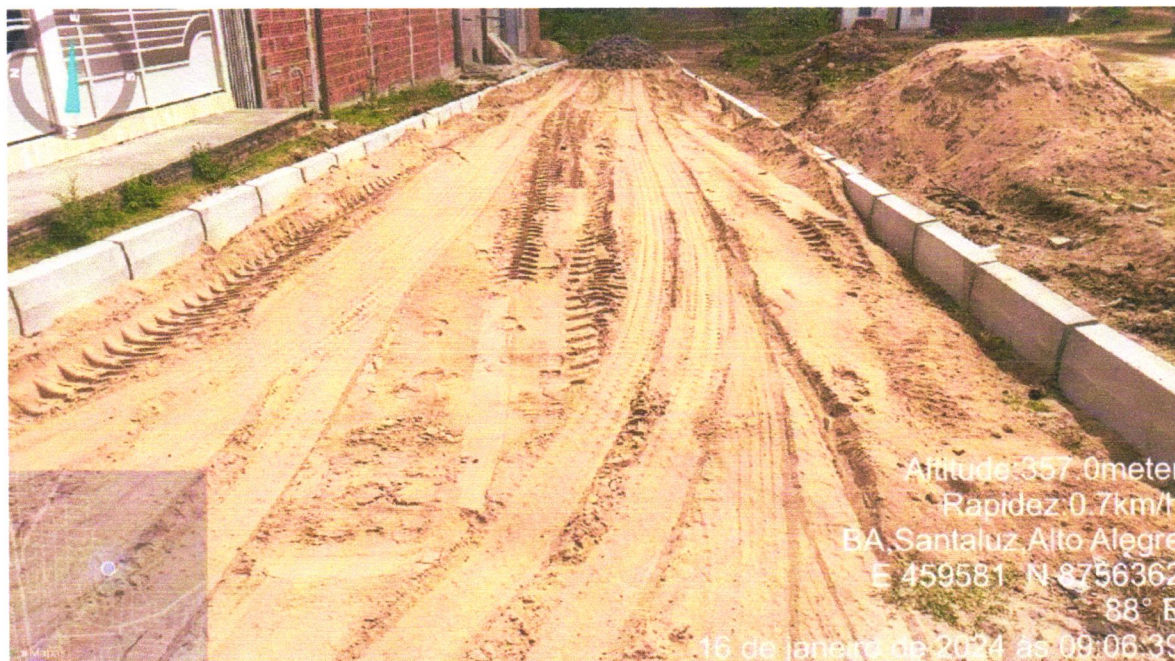
Execução de pavimentação cantinho da saudade rua 09
