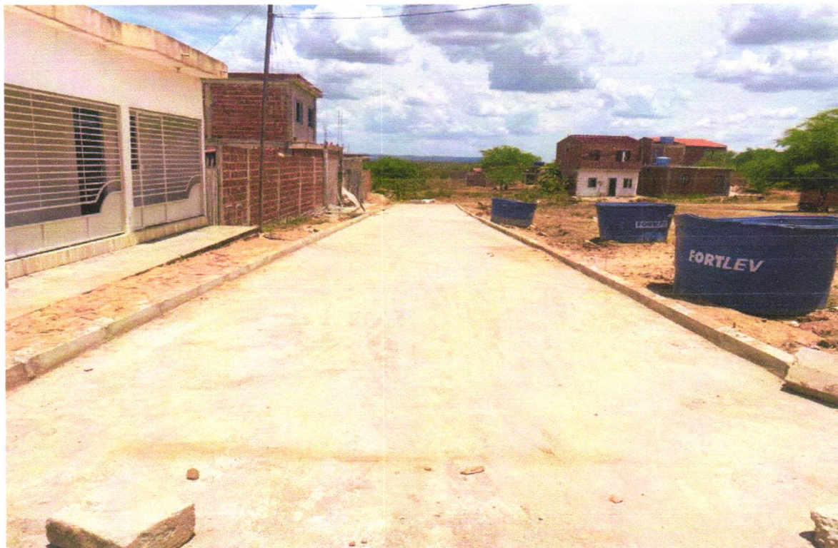
Execução de pavimentação cantinho da saudade rua 09
