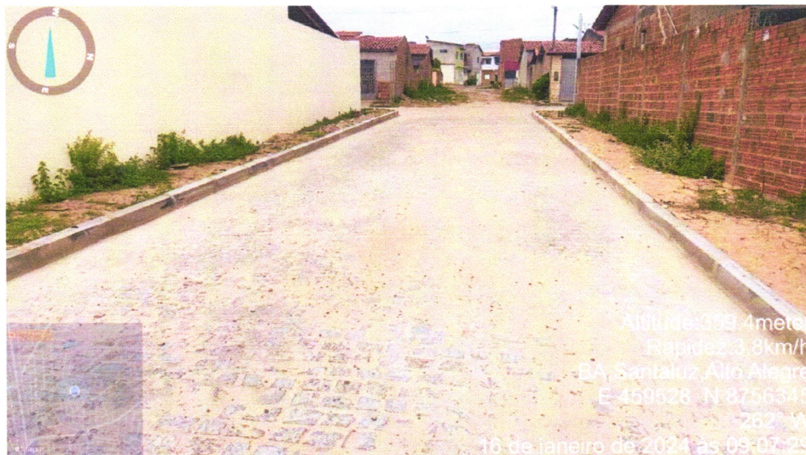
Execução de pavimentação cantinho da saudade rua 08
